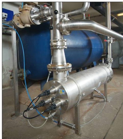
UV-System Typ Spektron 70 mit einem Durchsatz von 108 m 3 /h. Das System ist in einer Molkerei eingesetzt.
