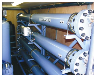
Umkehrosmoseanlage Typ EUROTEC 03-12
