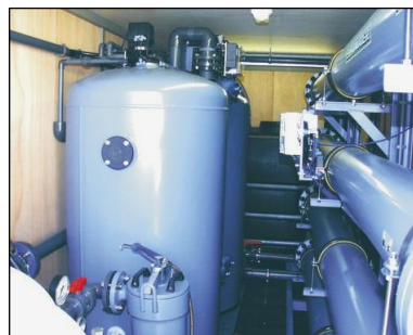
Enthärtungsanlage Typ SML 1802
