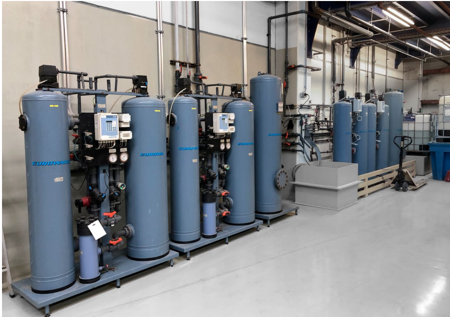
Mehrere Produktionslinien für VE-Wasser für die Vorbehandlung von Leichtmetallfelgen
